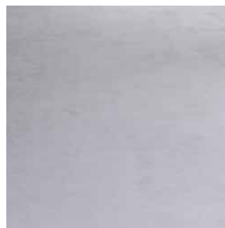
Betonilhas de cimento
